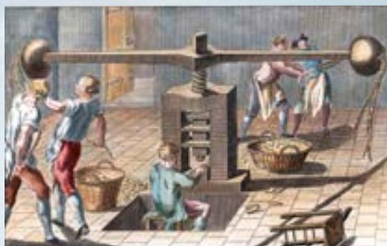
Ab dem 17. Jahrhundert kam das Stoßwerk – technisch eine Spindelpresse – bei der Münzprägung zum Einsatz.
